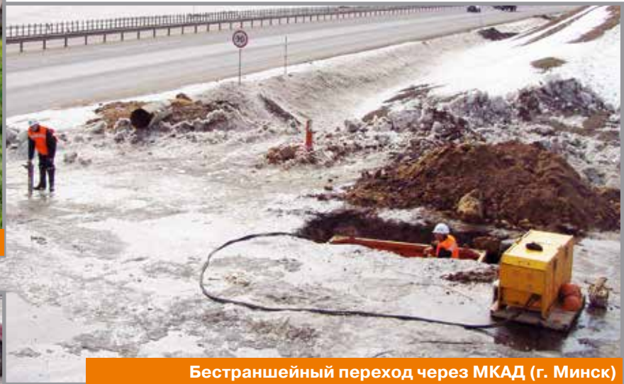
Работа МНБ-50 из опалубки ОР-1,5
