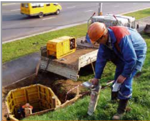
Работа МНБ-50 из опалубки ОР-1,5
