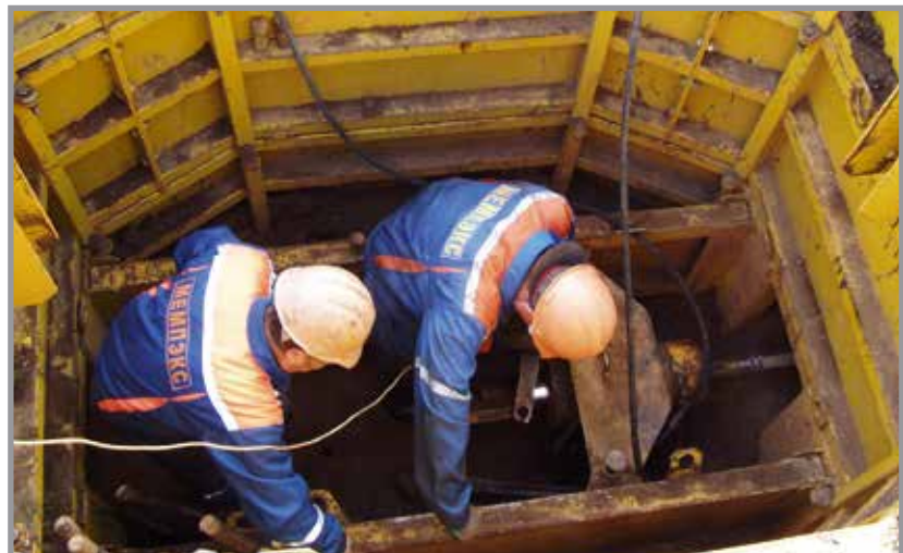
Замена трубы Д. 250 на Д. 315 мм по ул. Ташкентска (г. Минск)
