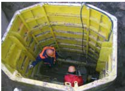
МНБ-50 в опалубке ОР-1,5
